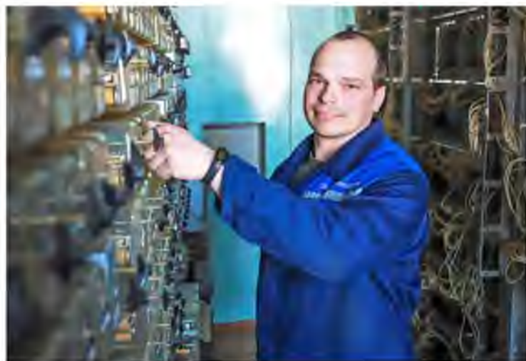
Александр Хохрин – электромонтёр электронной централизации и блокировки
