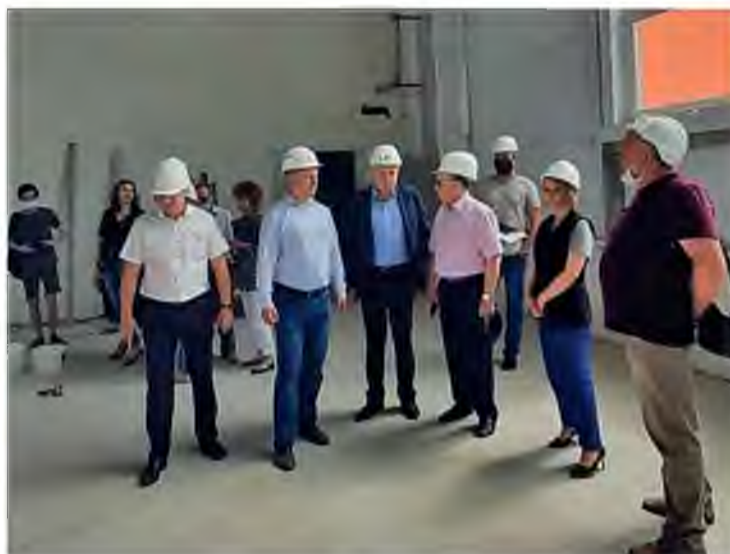
Инспекция строящегося физкультурно-оздоровительного комплекса на Певческом поле
